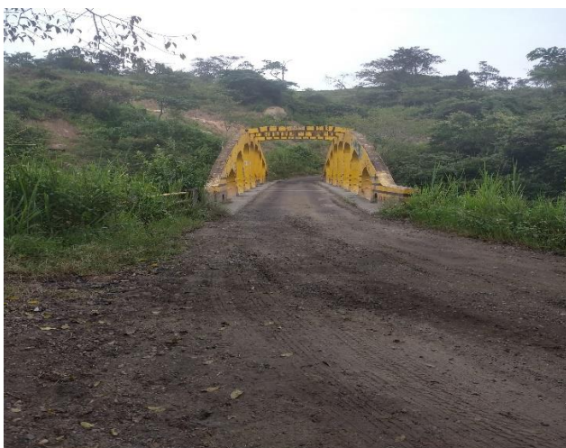
Figura 26. Carretera Km 8 vía Chaguaní – Bogotá. Autoría propia (2019).
