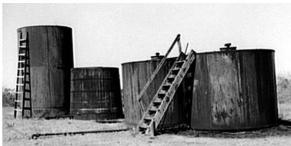
Figura 26. Primeros tanques en madera para almacenamiento (Nakagawa, 2013)
