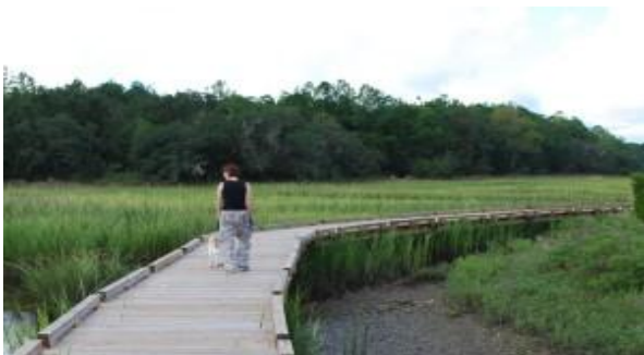
Figura 39 Puentes resistentes. (Un dos tres por mi, 2014).
