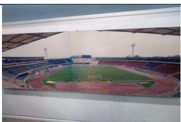
Figura 32 panorámica del estadio antes de su última remodelación Fuente: propia
