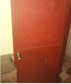
Figura 33 Puerta área B
