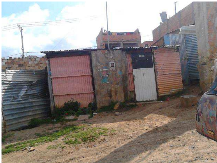
Figura 12. Fotografía estado viviendas de asentamientos sobre la ronda de la Quebrada Limas. Zapata, K. & Hernández, S. (2018). Autor.
