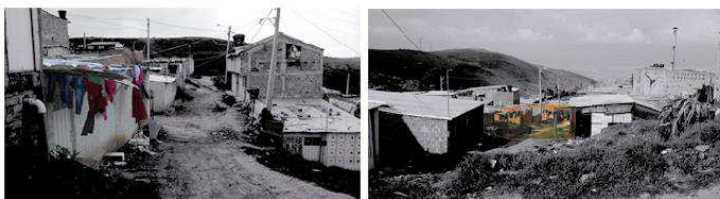
Figura 42. Imágenes del estado actual del lugar. Zapata, K. & Hernández, S. (2018). Autor.
