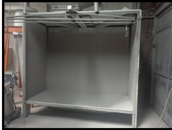
Ilustración 13 Cabina de Pintura Limpia.
