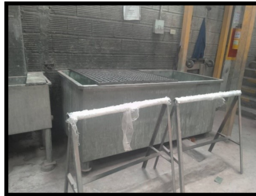
Ilustración 9 Tanque n° 3 utilizado para el Lavado de Piezas.
