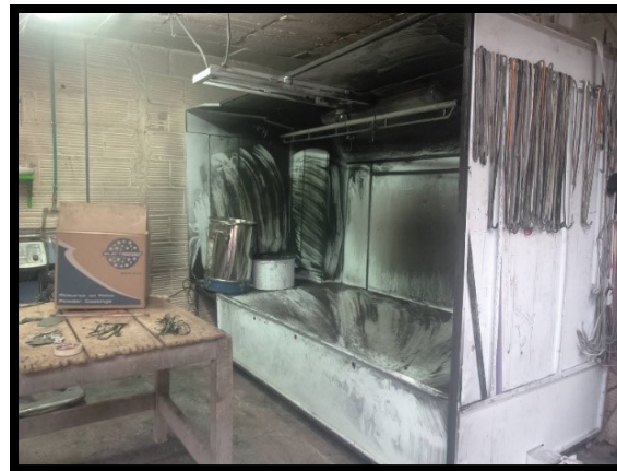
Ilustración 14 Cabina de Pintura Después de Utilizada.
