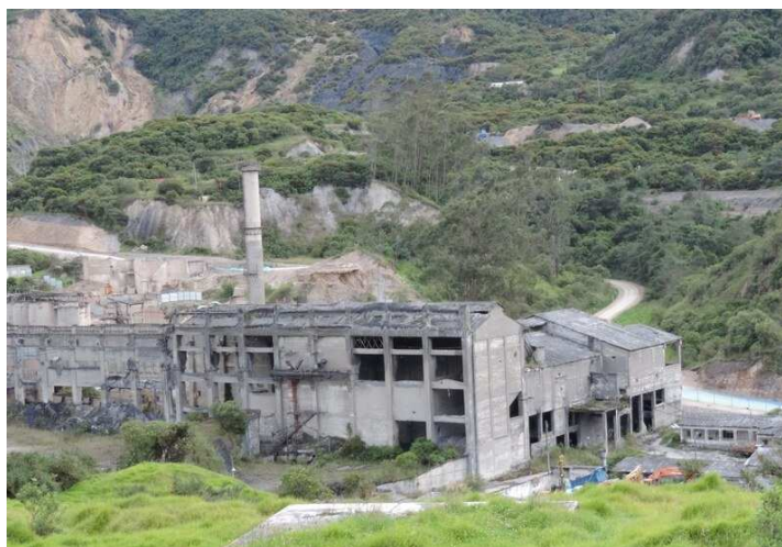
Imagen 35 Planta de cemento Samper
