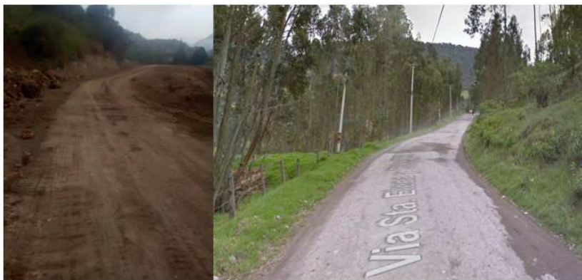
Imagen 32 Estado de la carretera
