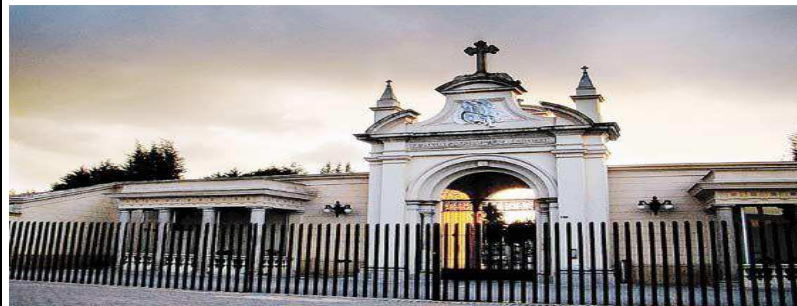
Figura 14. Cementerio central. Cortes Juan (2014)
