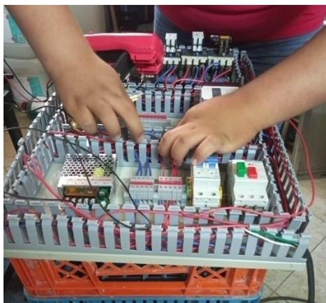
**Figura 53.** Cableado tablero (Elaboración propia).
