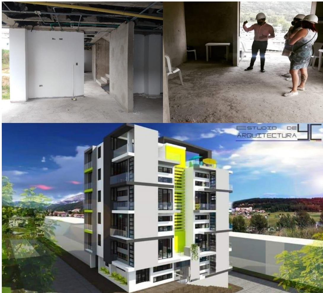
Figura 5. Construcción Torre Iconik. GRUPO Y.C CONSTRUCTORA (s.f.)
