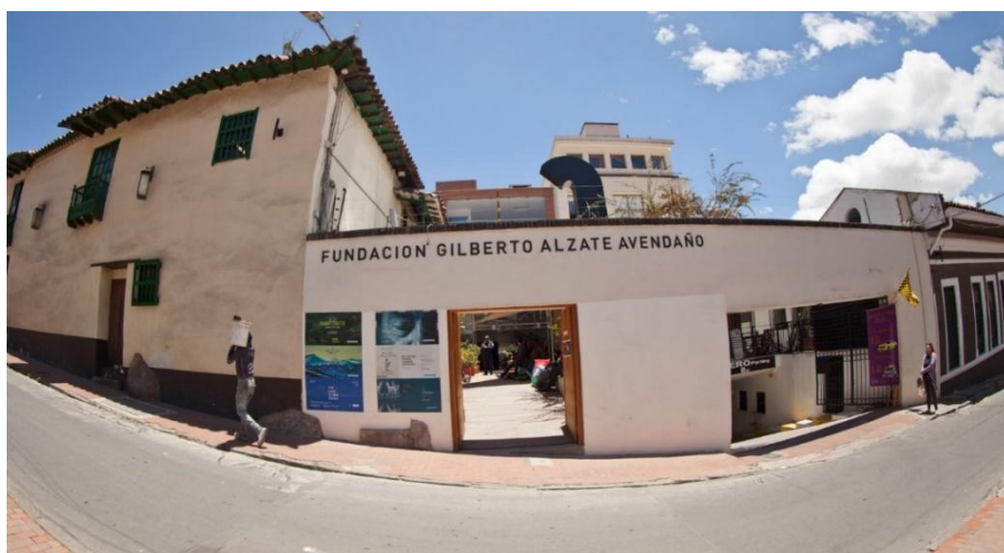
Figura 49. Fundación Gilberto Álzate Avendaño. Fundación Gilberto Álzate Avendaño. (s.f.).
