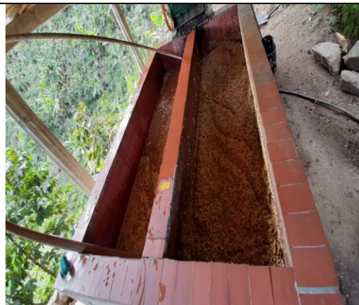
Figura 42: Señalamiento al tanque #2. Elaboración propia (2020).
