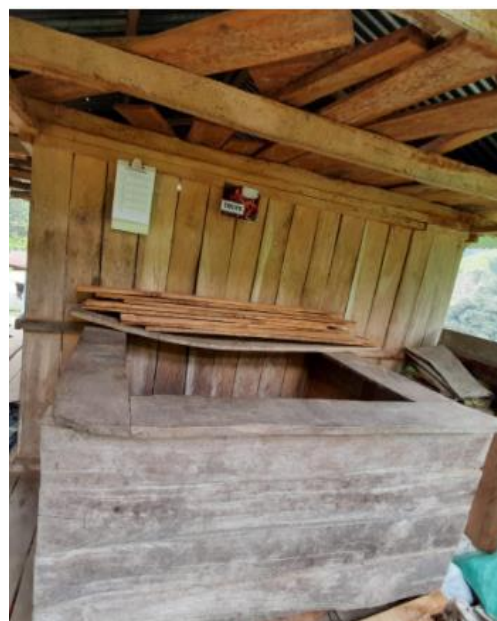
Figura 39: Señalamiento de la tolva. Elaboración propia (2020).
