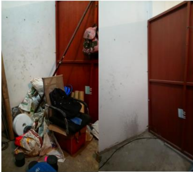
Figura 28. Recursos obsoletos e implementación de limpieza en la bodega de la empresa M&M. Elaboración propia.
