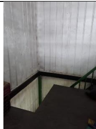
Figura 53. Nivel 2 borde y barandal sin obstáculos. Autoría propia
