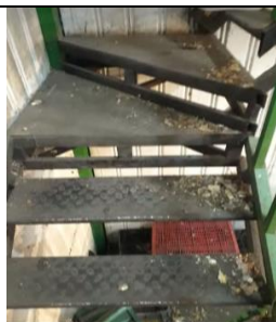
Figura 64. Escaleras sucias. Autoría propia
