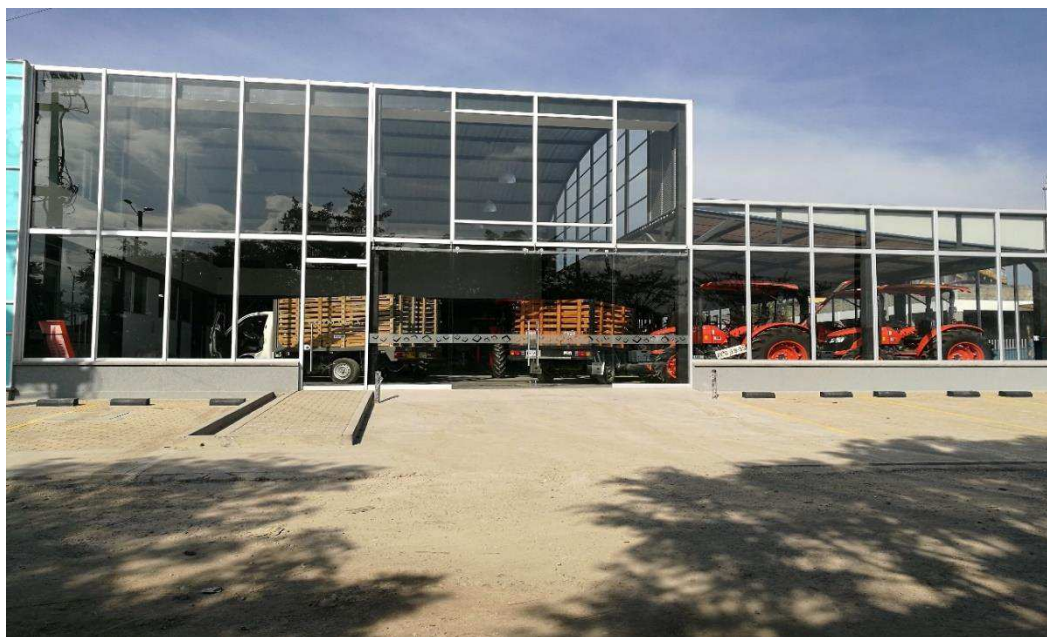
Figura 4 . Fachada empresa Luyma S.A. Nota: Autoría propia
