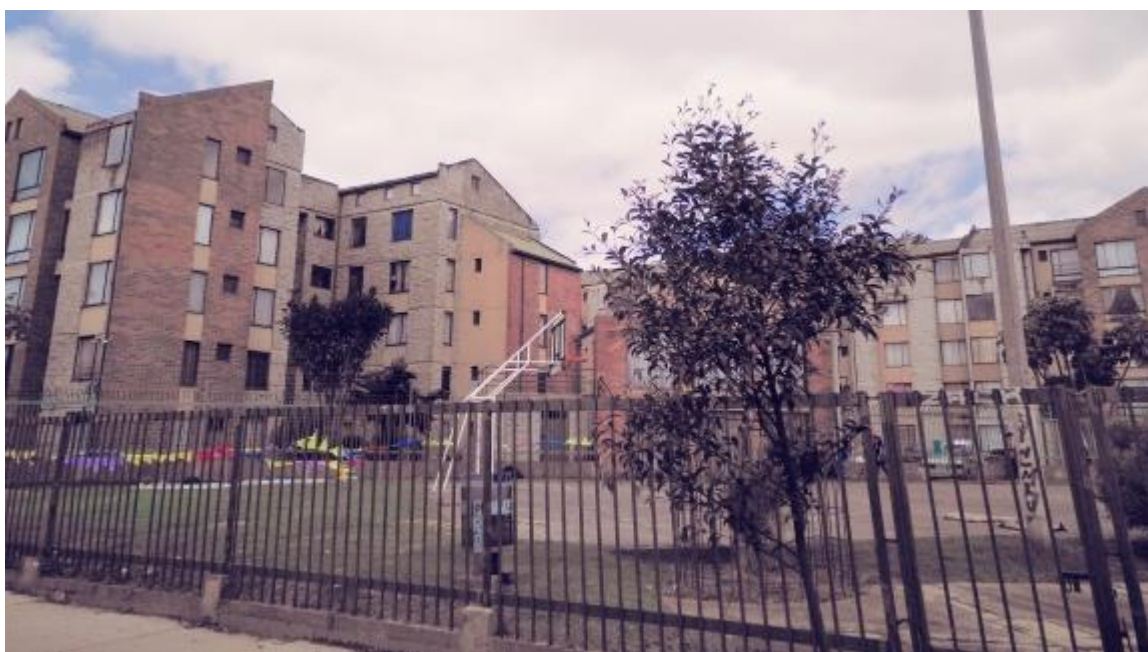
Figura 13. Propiedad Horizontal en el barrio El Tunal. Autoría propia.
