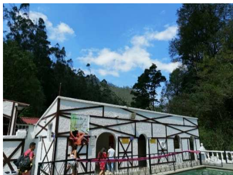
Figura 20. Baños. Los autores (2019).
