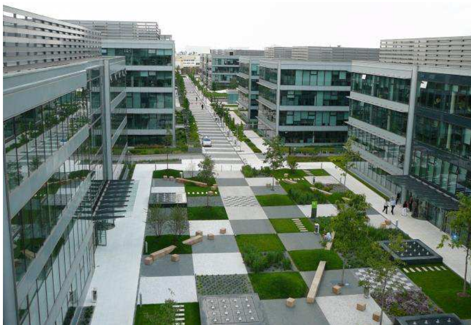
Figura 6. Referente centro de manzana. fuente plataforma de arquitectura
