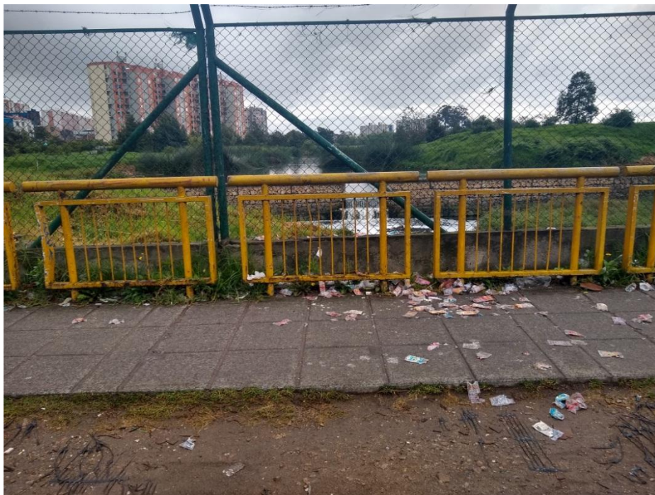
Figura 5. Humedal “El Burro” – Afectación por residuos. Propia (2019)
