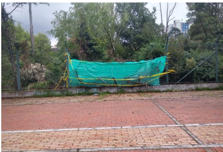
Figura 6. Humedal “El Burro” – Afectación a malla eslabonada. Propia (2019)
