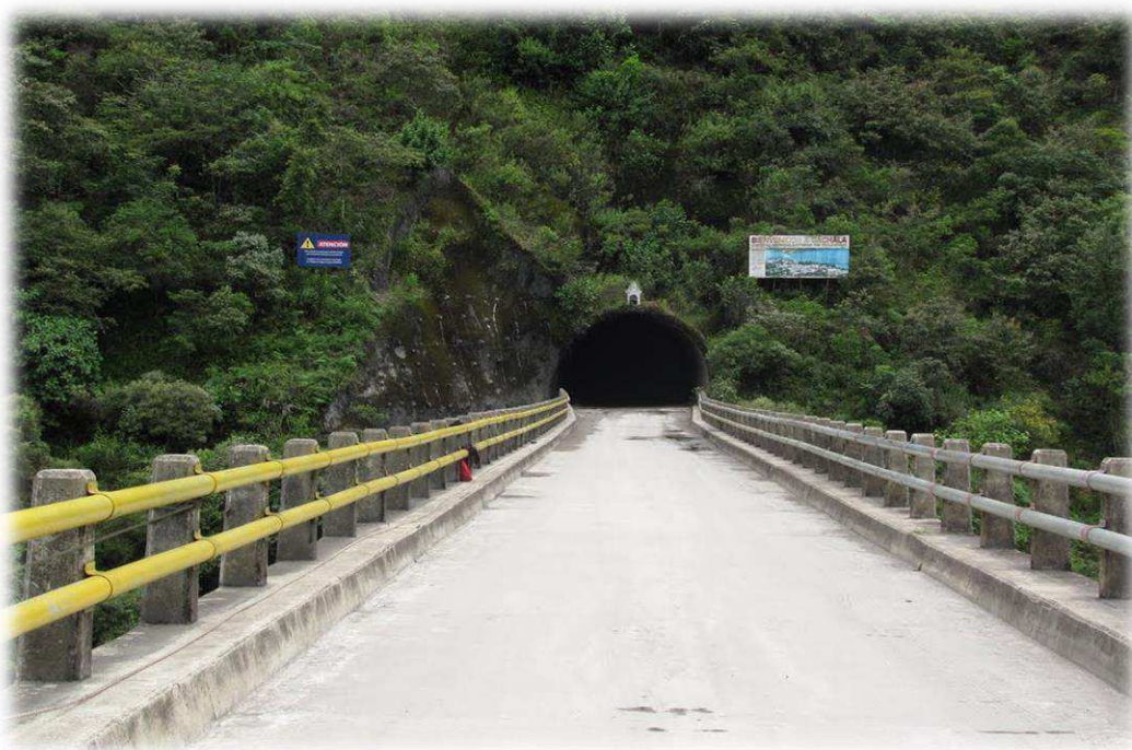
Ilustración 18: Túnel entrada Gachalá vía Gama
