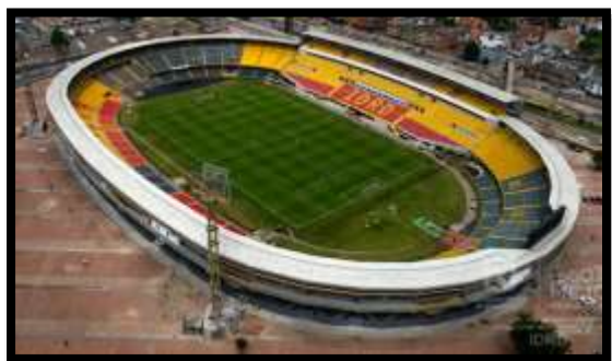
Figura 2. Estadio Nemesio Camacho. Autoría propia.
