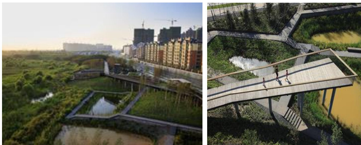
Figura 5. Qunli, parque de humedales y aguas-lluvias. Turenscape imágenes de Archidaily (2019)
