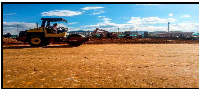
Figura 6. Rellenos estabilizados ejecutados por R.O Ingeniería. (R.O Ingeniería Ltda. 2016)
