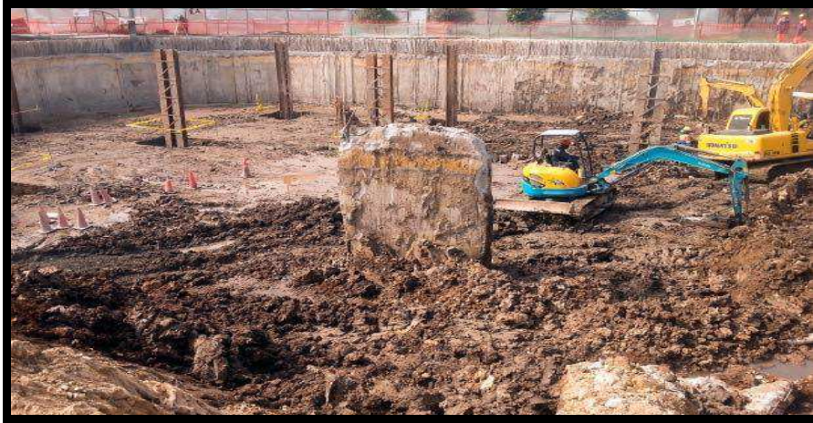
Figura 2 Excavaciones ejecutadas por R.O Ingeniería. (R.O Ingeniería Ltda. 2016)
