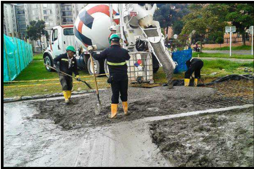
Figura 1 Obras civiles ejecutadas por R.O Ingeniería. (R.O Ingeniería Ltda. 2016)
