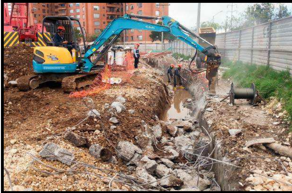
Figura 4 Demoliciones ejecutadas por R.O Ingeniería. (R.O Ingeniería Ltda. 2016)
