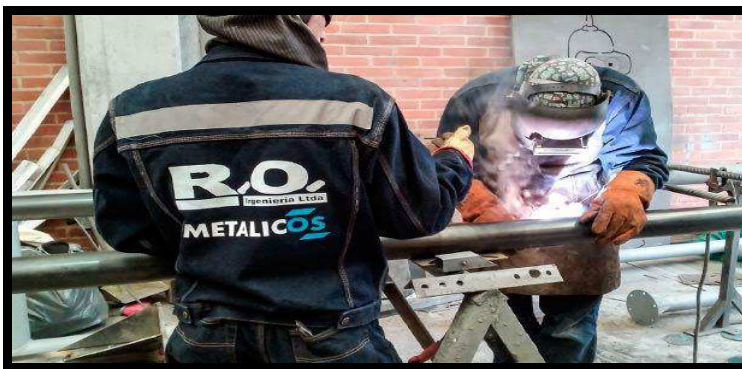
Figura 3 Montajes ejecutados por R.O Ingeniería. (R.O Ingeniería Ltda. 2016)
