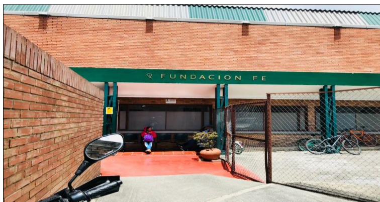
Figura 54. Instalaciones Fundación Fe-Fuente propia
