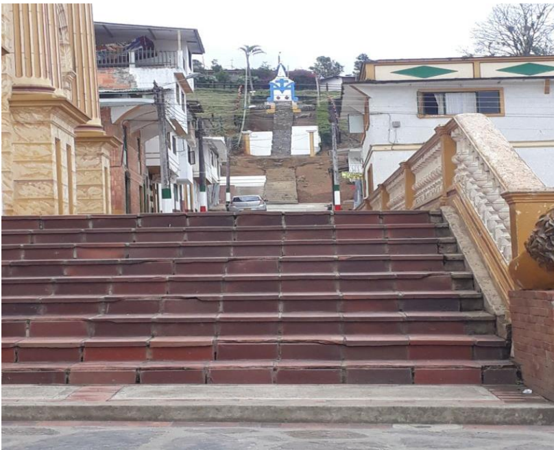
Figura 59. Escaleras iglesia. Fuente: Linares “et al”
