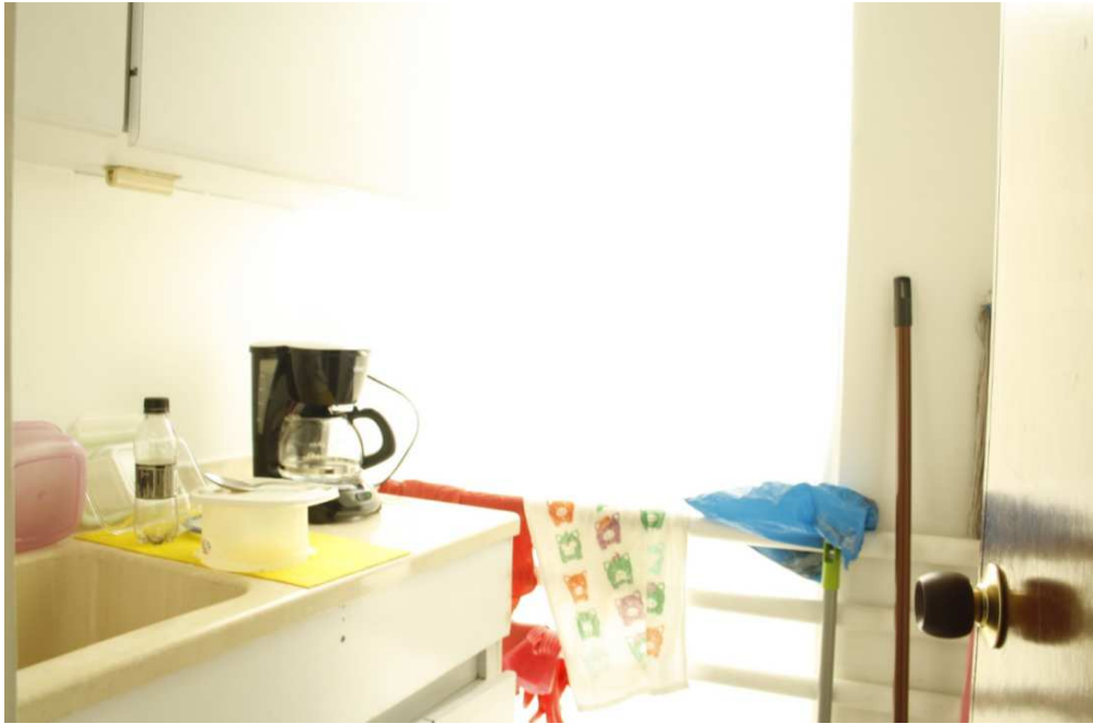
Figura 42 Cuarto de aseo.
