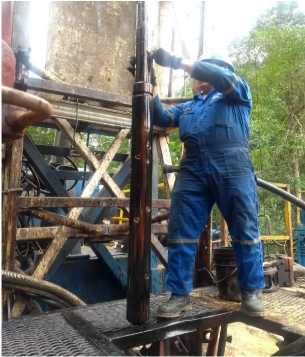
Figura 14. Cañón detonado después de operación Casing Gun (octubre 2019).
