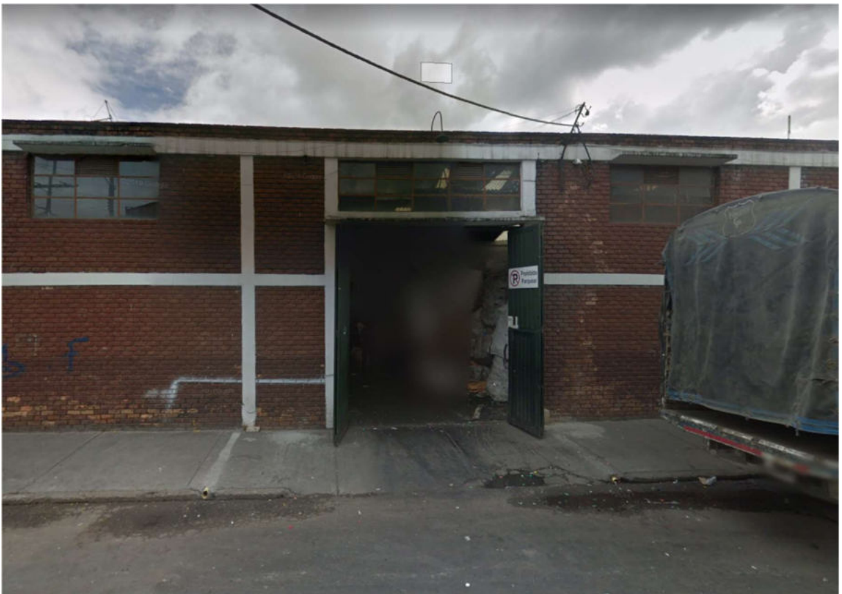
Figura 11. Entrada almacén secundario
