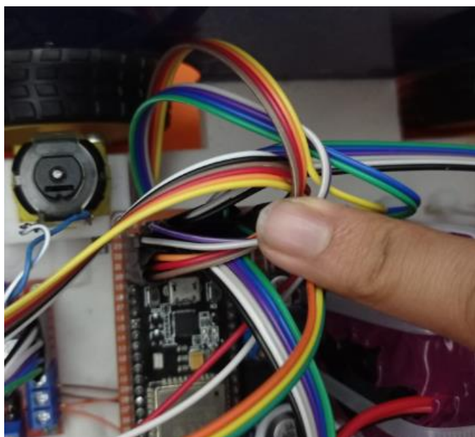
Figura 107. Cableado de los elementos del robot AGV. Elaboración propia (2022).
