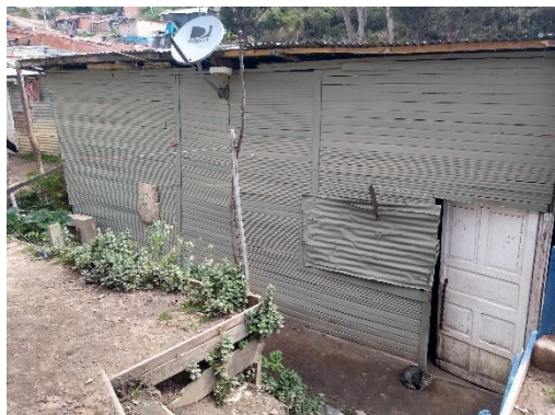
Fotografías de la fachada
