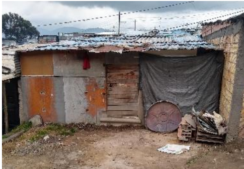
Fotografías de la fachada
