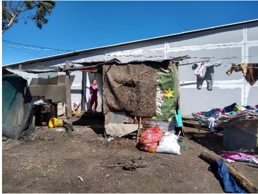
Fotografías de la fachada
