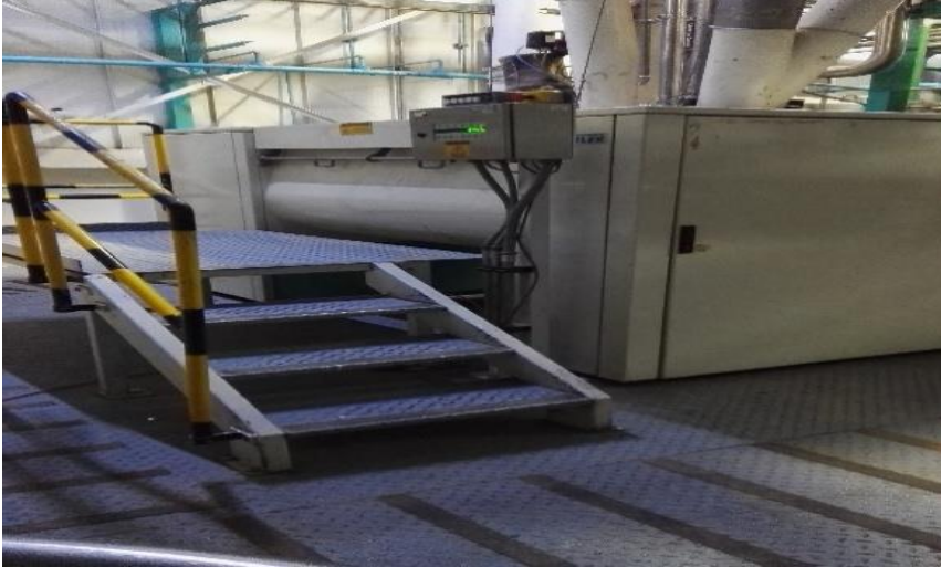
Figura 23. Mezclador Casa Luker. Autoría propia (2019).
