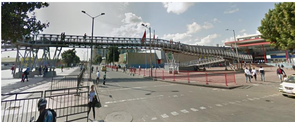
Figura 11. Imagen tomada de la avenida ciudad de Cali ingreso a Plaza Imperial. Autoría propia.
