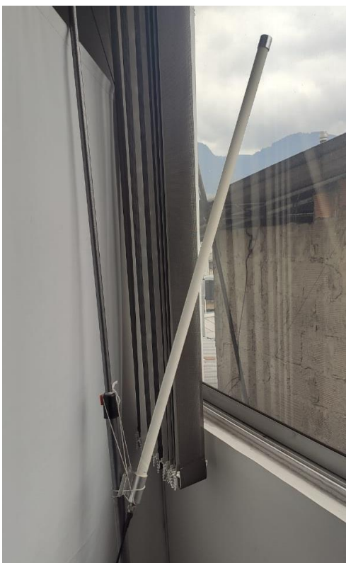
Figura 14. Montaje antena entorno comercial. Elaboración propia.
