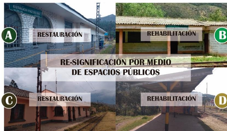
Figura 35. Estado de las estaciones del tren. Autoría propia. (2019)
