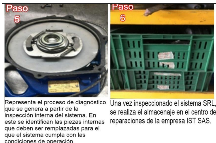
Figura 14. Inspección y almacenamiento del equipo. Elaboración propia
