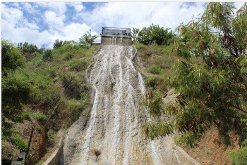
Figura 36 Torrentismo. Tomada autoría propia
