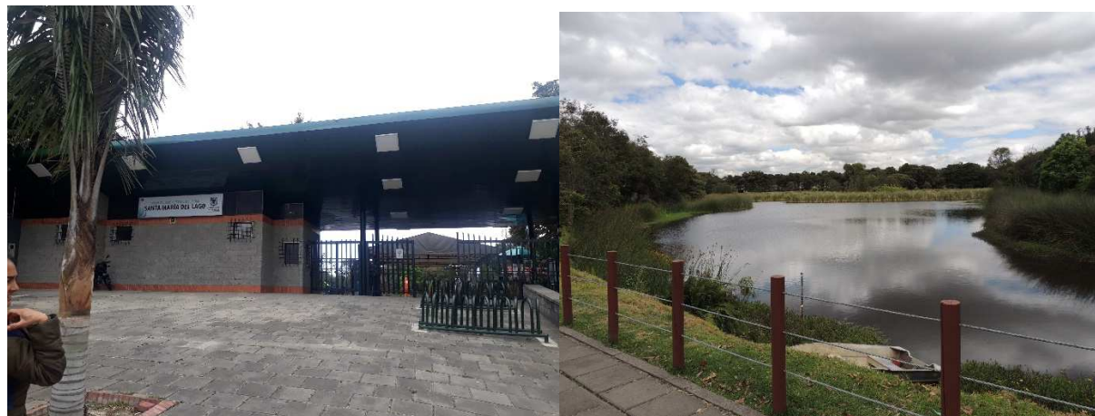
Figura 27. Condiciones de planta y áreas naturales. Fuente propia.
