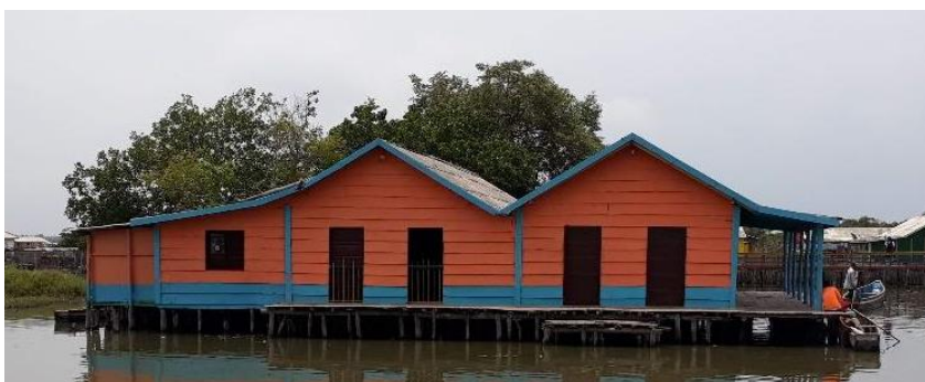
Figura 37. Vivienda sobre palafitos. Fuente propia.
