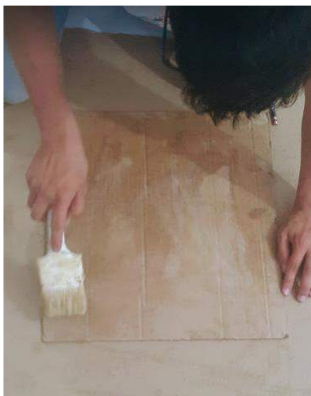
Figura 59. Aplicación de pegante a las láminas. Elaboración propia.
