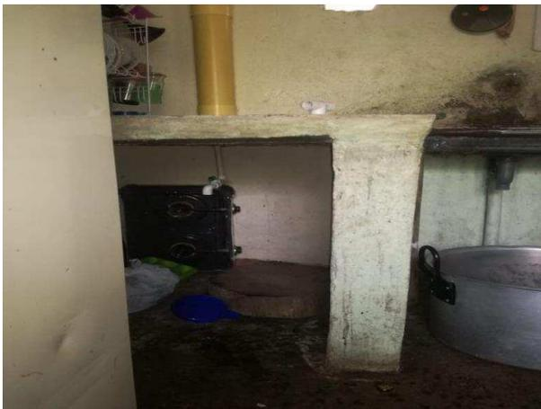
**Figura 86.** Implementación perforación mesón, para salida de caudal de  $\frac{1}{2}$ ". (Elaboración propia).
