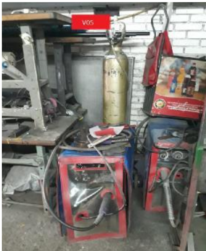
Figura 34. Foto área de soldadura N° 2 C&C.
