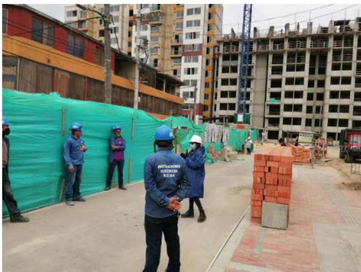
Figura 4. Proyectos realizados por la empresa Instaelectricos RMS S.A.S (2021).
