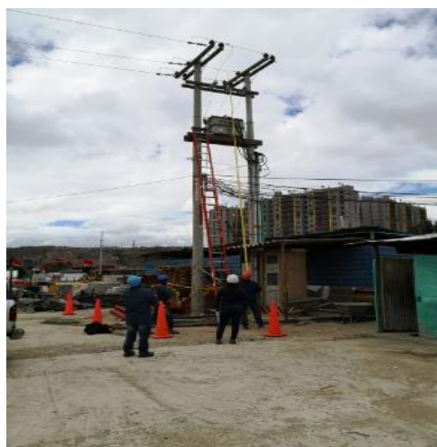
Figura 8. Proyectos realizados por la empresa Instaelectricos RMS S.A.S (2021).
