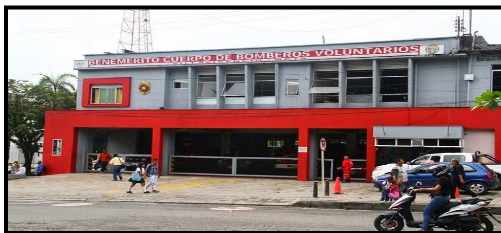
Figura 3. Fachada Benemérito Cuerpo de Bomberos Voluntarios de Villavicencio. Cuerpo de Bomberos de Villavicencio. (2021)
