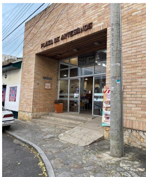
Figura 8. Rampas de acceso II. Elaboración propia (2021)
