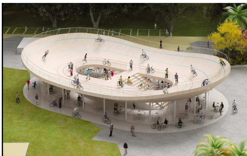
Figura 6. Fotografía Pabellón de Bicicletas, NL Architects (2012)
