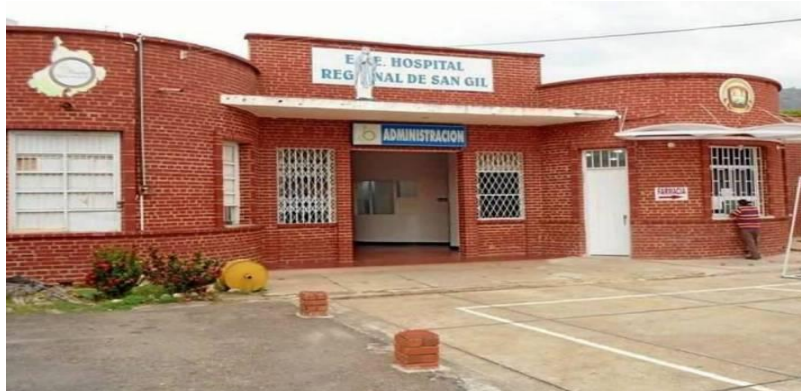
Figura 48. Hospital Regional de San Gil. Google imagen (2018)
