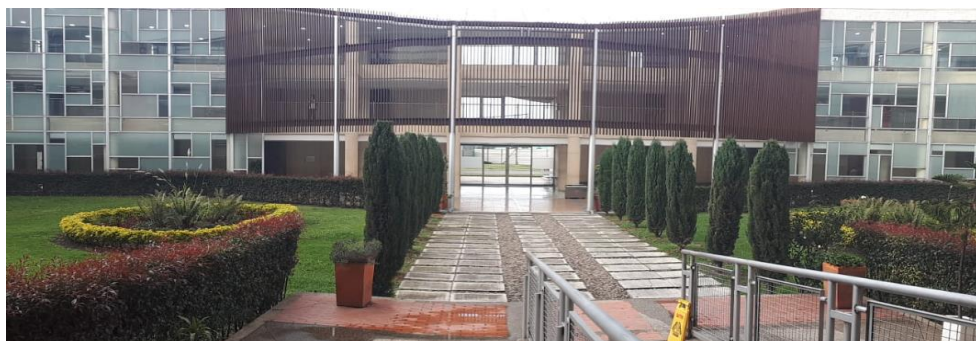
Figura 04. Edificio Fray Abel Salazar.
